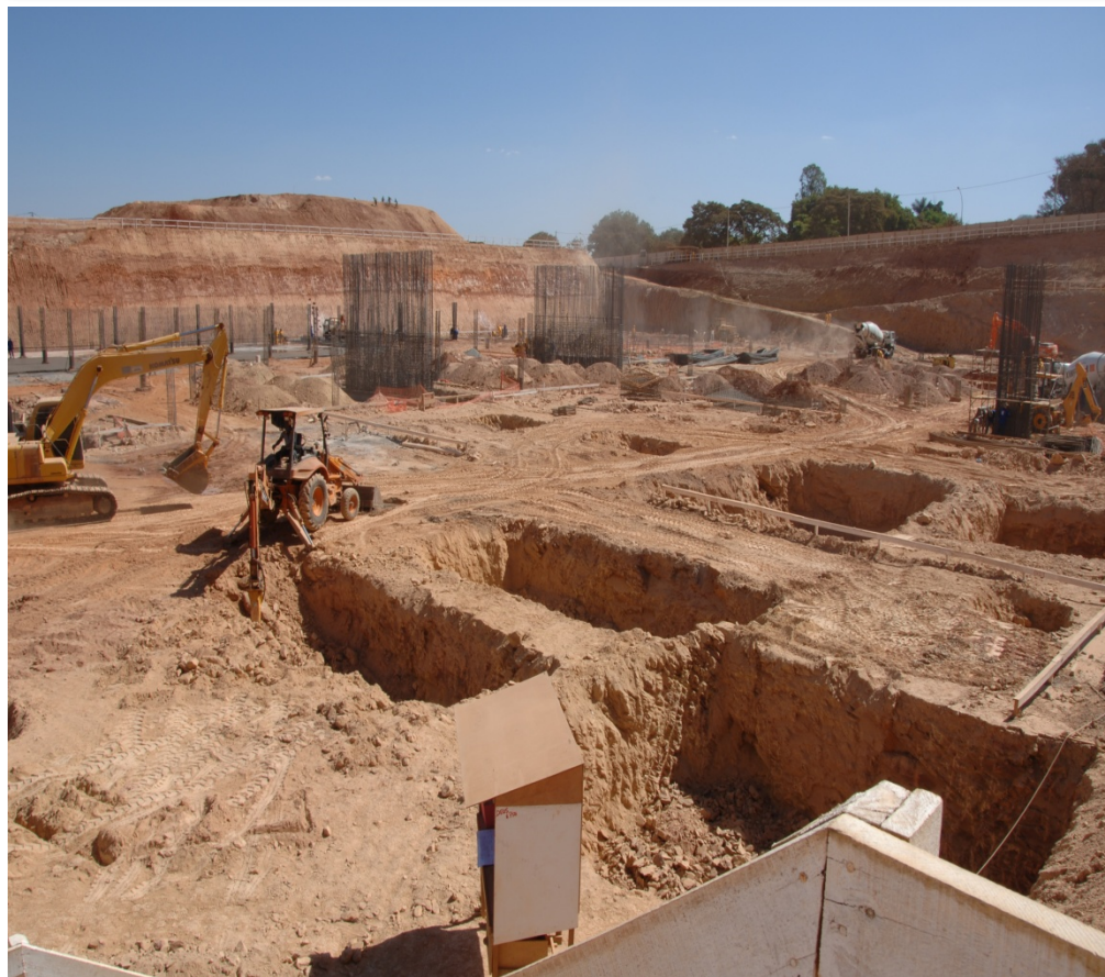
Foto 6 – Escavação Sapatas Trecho I
