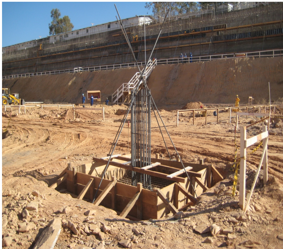
Foto 12 – Forma/Ferragem de Sapatas
