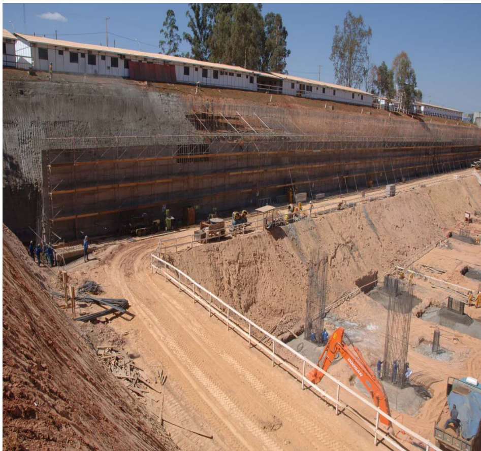
Foto 24 – Forma/Ferragem/Concreto – Muro de Arrimo Eixo 1
