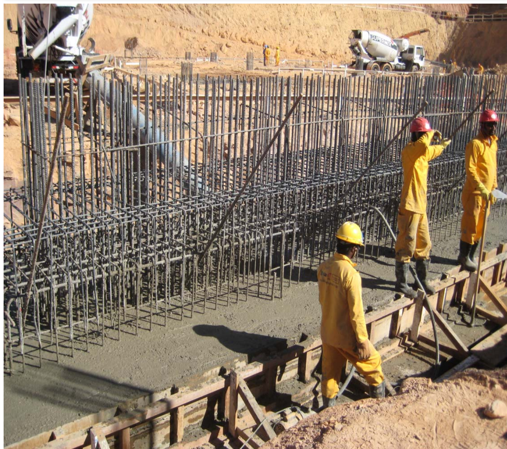
Foto 16 – Forma/Ferragem/Concreto de Sapatas
