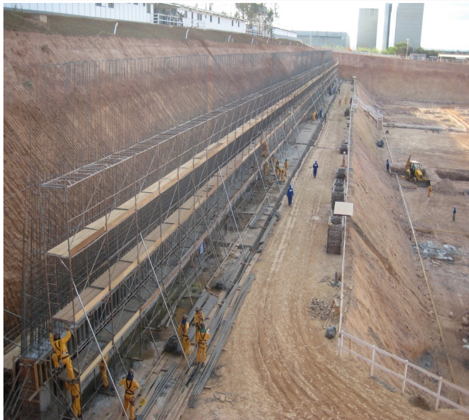
Foto 20 – Forma/Ferragem Muro de Arrimo Eixo 1
