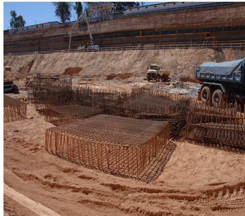
Foto 11 – Ferragem de Sapatas
