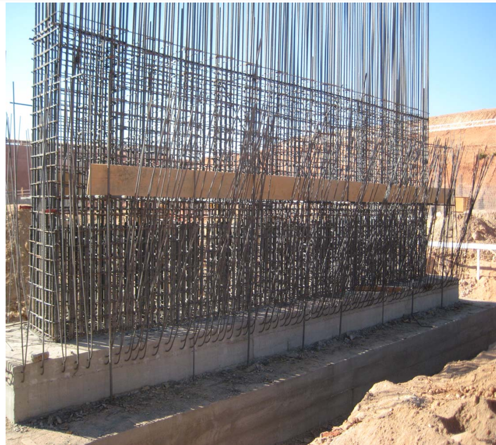
Foto 19 – Forma/Ferragem/Concreto de Sapatas
