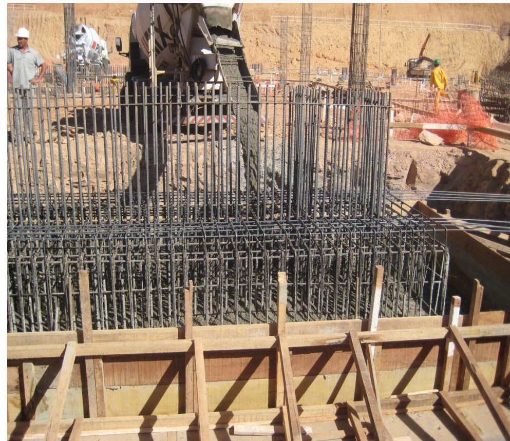
Foto 15 – Forma/Ferragem/Concreto de Sapatas
