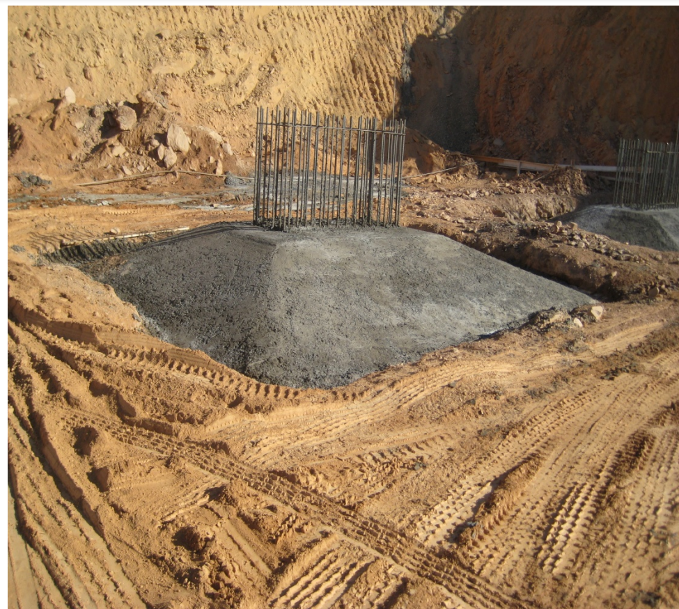
Foto 17 – Forma/Ferragem/Concreto de Sapatas
