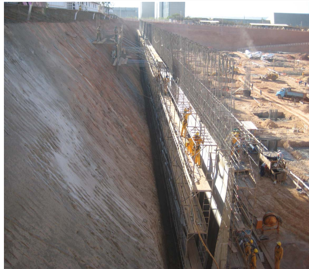
Foto 25 – Forma/Ferragem/Concreto – Muro de Arrimo Eixo 1
