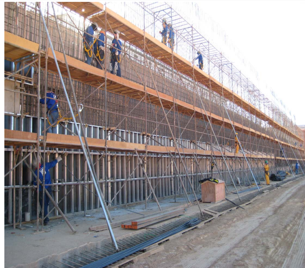
Foto 21 – Forma/Ferragem/Concreto – Muro de Arrimo Eixo 1
