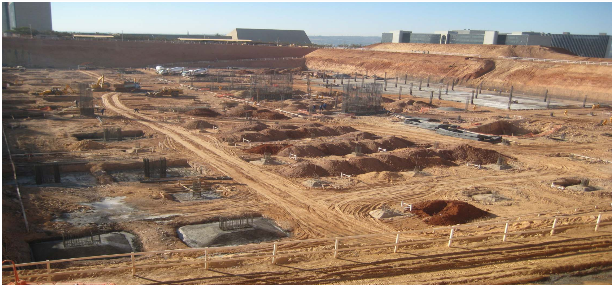
Foto 1 – Vista Geral do 3º Subsolo
