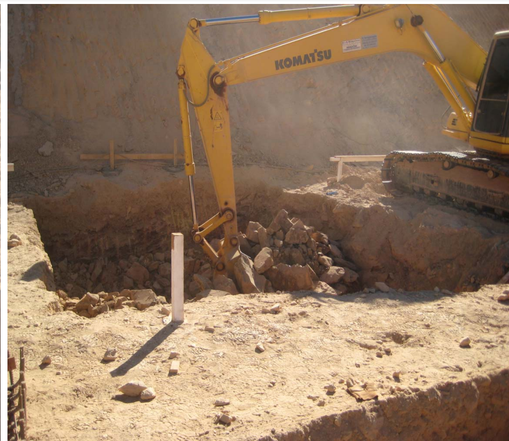
Foto 9 – Escavação Sapatas Trecho II
