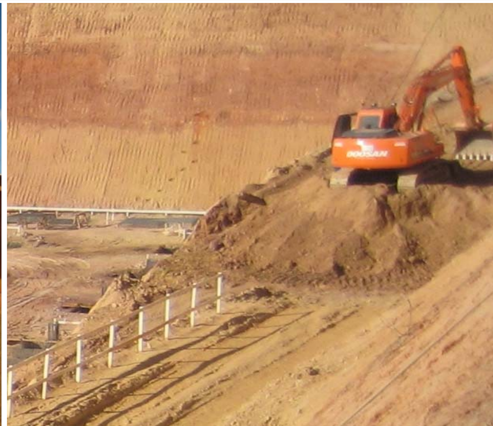
Foto 5 – Terraplenagem – Corte da rampa de acesso
