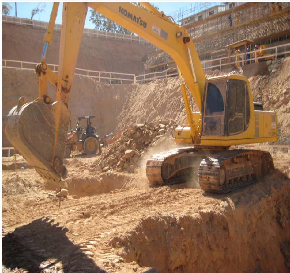
Foto 8 Escavação Sapatas Trecho I
