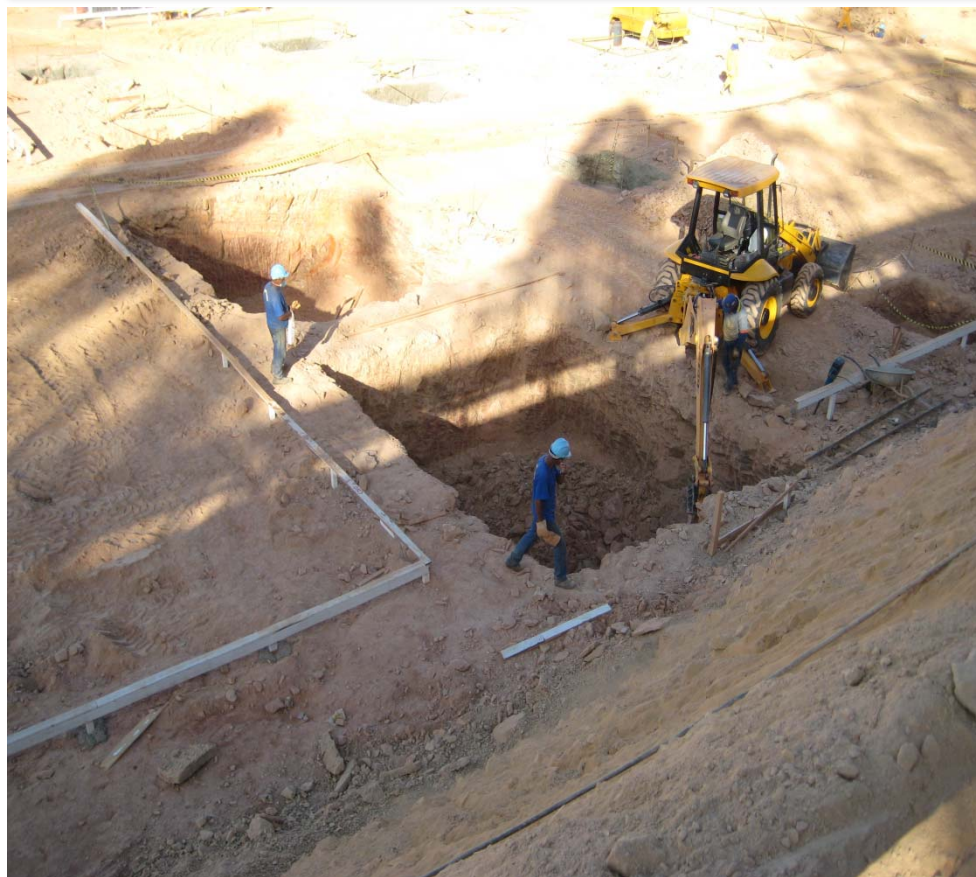
Foto 10 – Escavação de Sapatas - Trecho I
