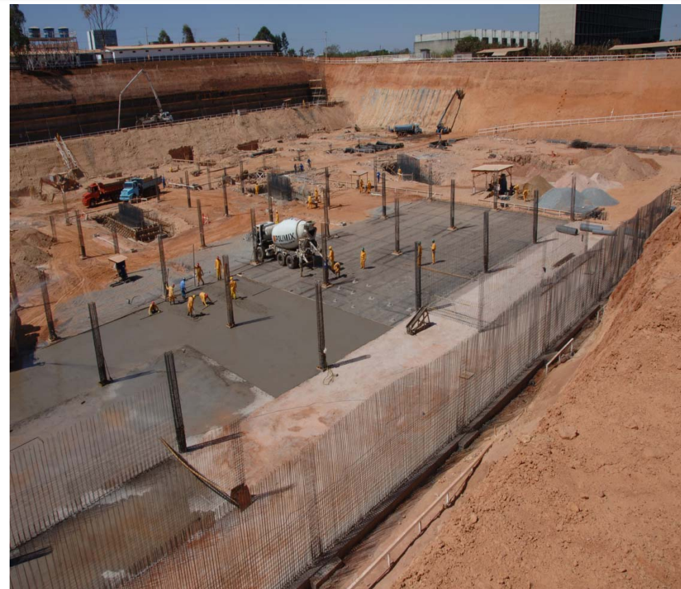
Foto 3 – Vista Parcial do 3º Subsolo
