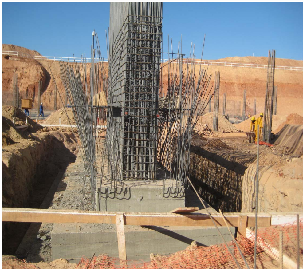
Foto 18 – Forma/Ferragem/Concreto de Sapatas
