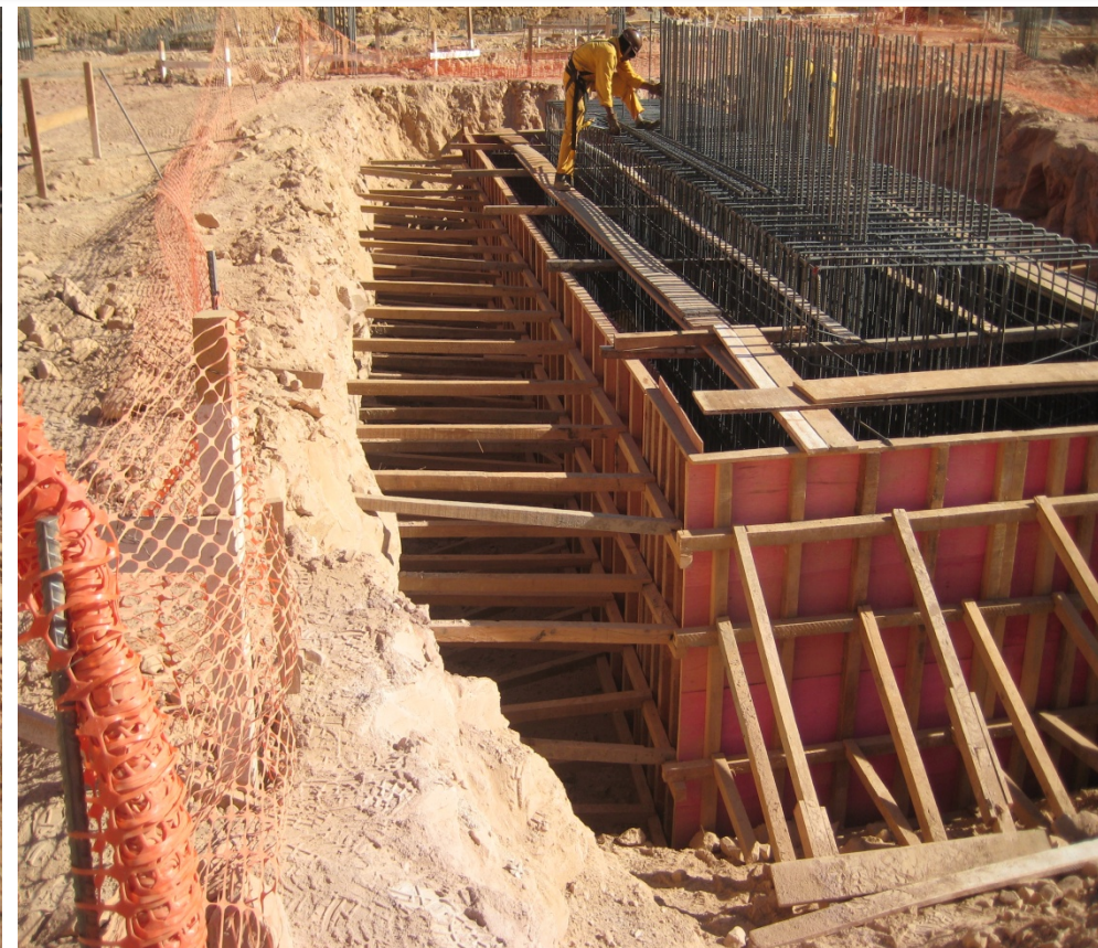
Foto 13 – Forma/Ferragem de Sapatas
