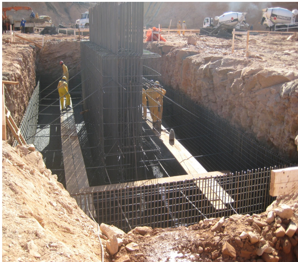
Foto 14 – Forma/Ferragem de Sapatas
