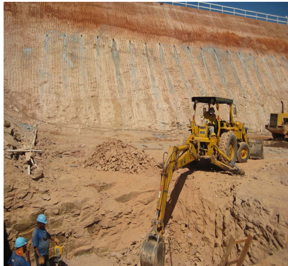
Foto 7 – Escavação Sapatas Trecho III
