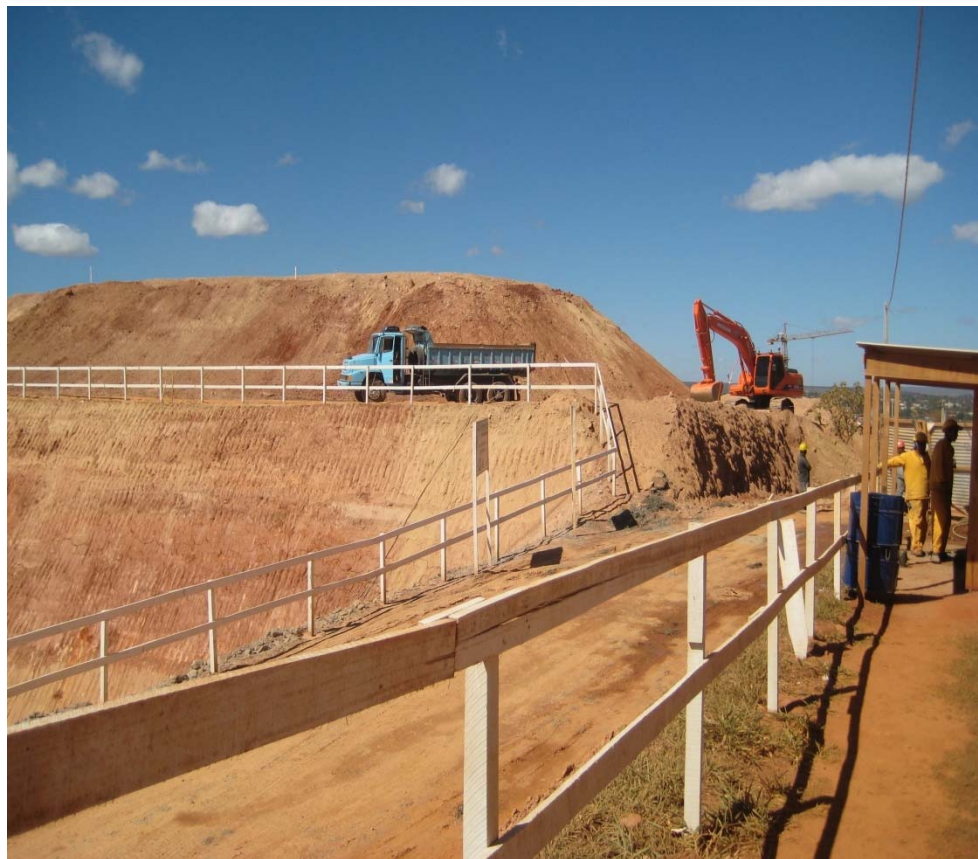
Foto 4 – Terraplenagem – Corte da rampa de acesso
