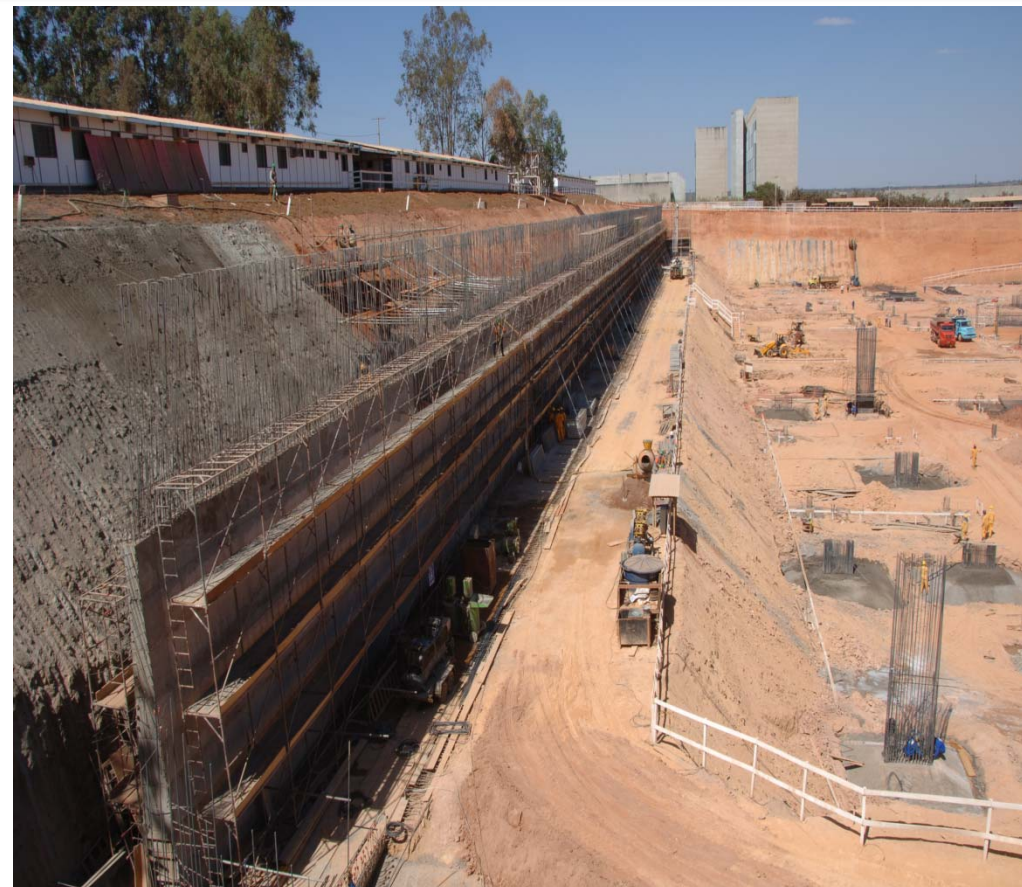
Foto 23 – Forma/Ferragem/Concreto – Muro de Arrimo Eixo 1
