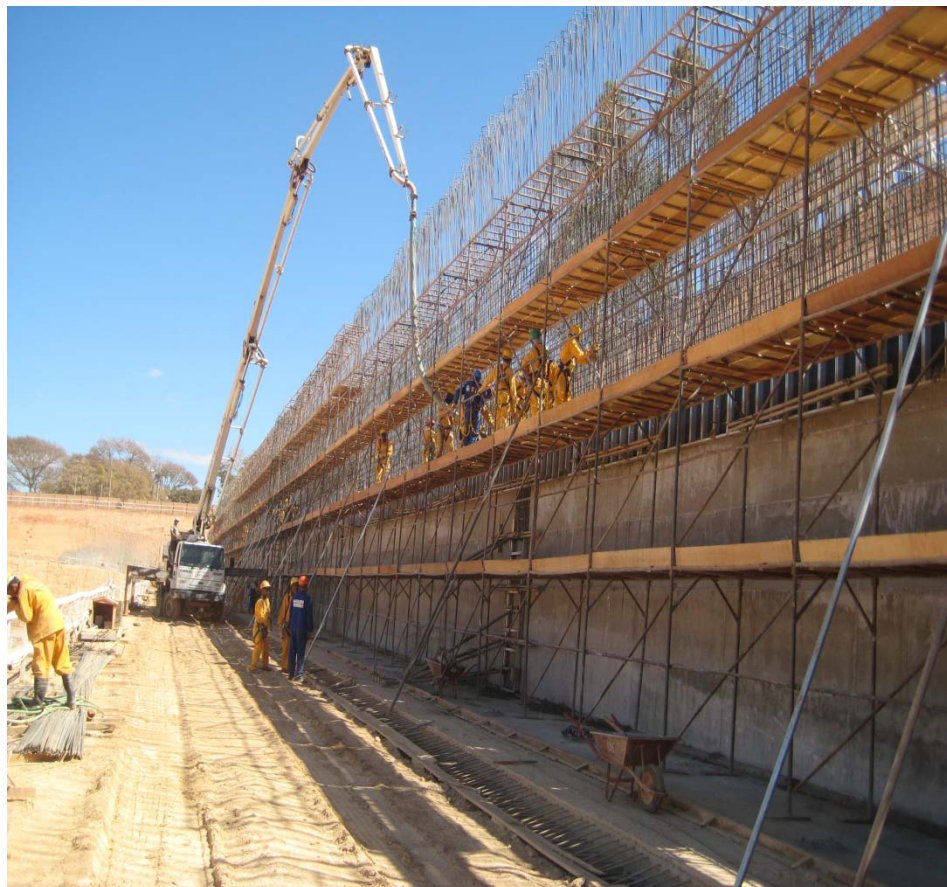
Foto 22 – Forma/Ferragem/Concreto – Muro de Arrimo Eixo 1
