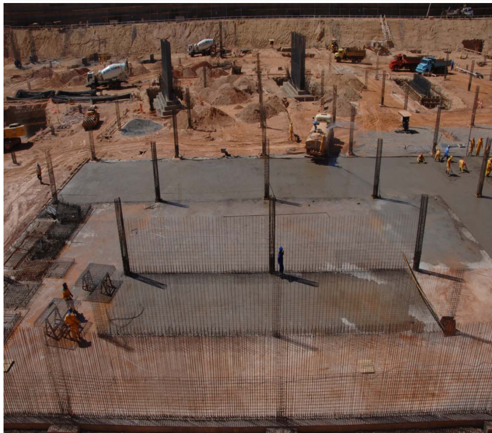
Foto 2 – Vista Parcial do 3º Subsolo
